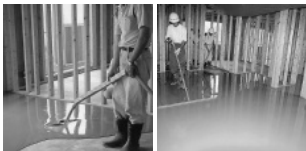
写 2 木造アパート 2 階床面へ「SL プラスター」を施工
