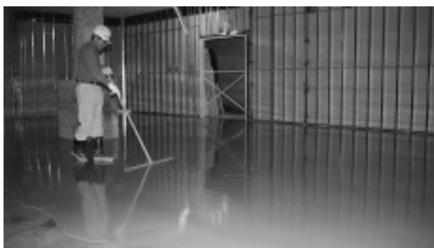
写1 「SL プラスター」の均し作業
